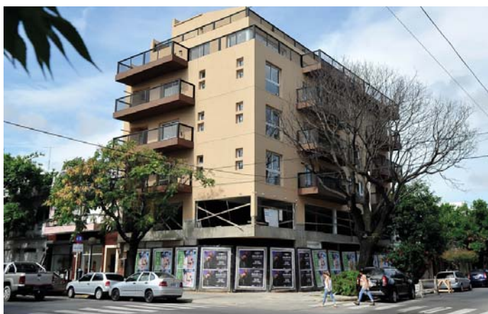
Obra con destino vivienda en la intersección de las calles Cuenca y Navarro.
