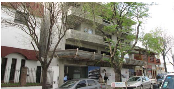
El barrio se caracteriza por poseer viviendas unifamiliares, incorpora viviendas multifamiliares de densidad media.
