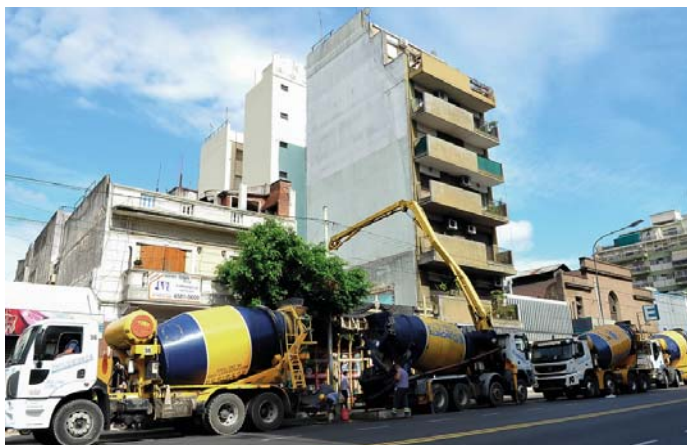
Trabajos de construcción en la Av. Juan B. Justo.
