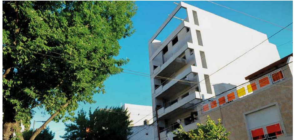
Vivienda Multifamiliar de densidad alta en construcción.
