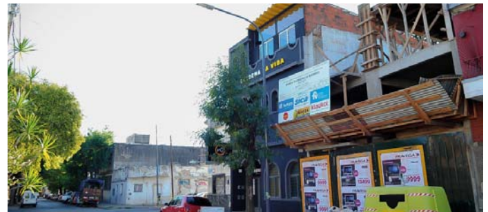
Edificio en obra en la Calle Alcaraz del barrio Monte Castro.
