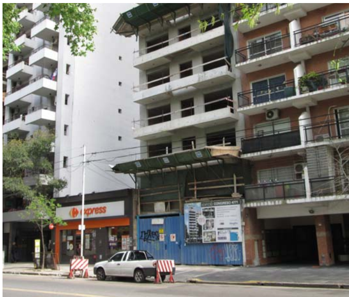
Intensificación de obras en la Av. Congreso que consolidan el tejido urbano.
